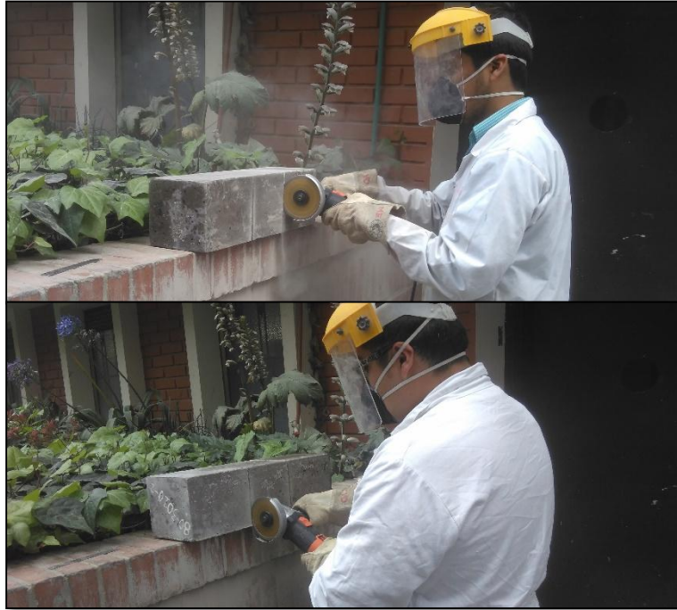
Imagen 33. Ranuras en las Viguetas
