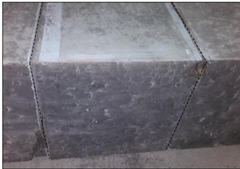
Imagen 44. Platinas Descentrada en Vigueta
