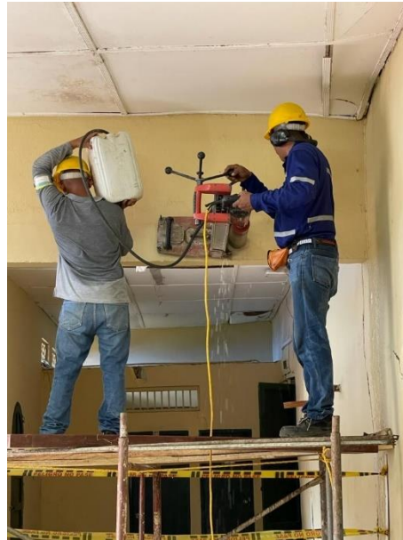
IMAGEN 3 EXTRACCIÓN DE NÚCLEOS EN VIGA ÁREA
