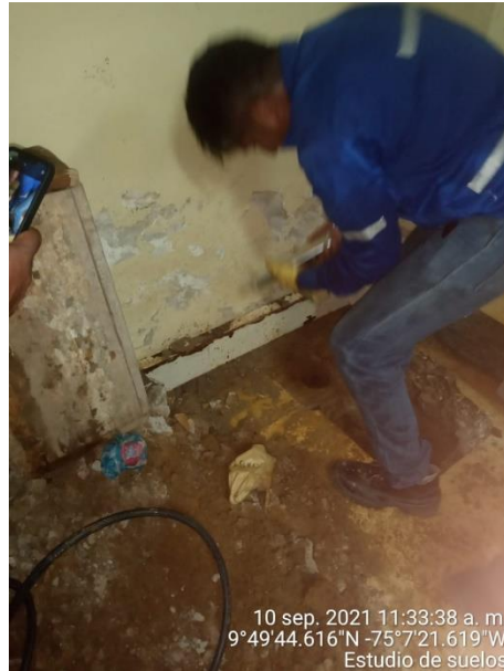
IMAGEN 9 PRUEBA DE ESCLERÓMETRO EN MURO BAHAREQUE RECUBIERTO DE MORTERO
