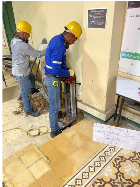
IMAGEN 5 EXTRACCIÓN DE NÚCLEOS EN CIMENTACIÓN (VIGA CICLÓPEA DE 40X39)
