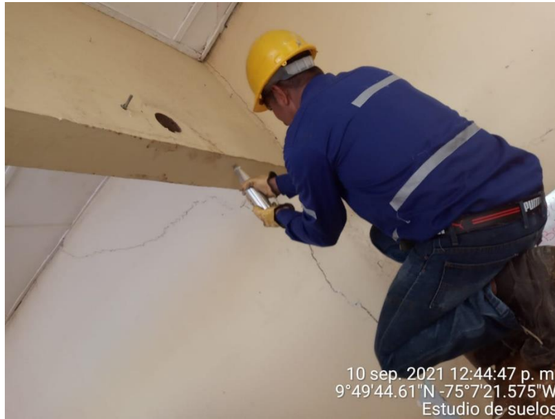
IMAGEN 7 PRUEBA DE ESCLERÓMETRO EN VIGA ÁREA 17X23 N+2.50
