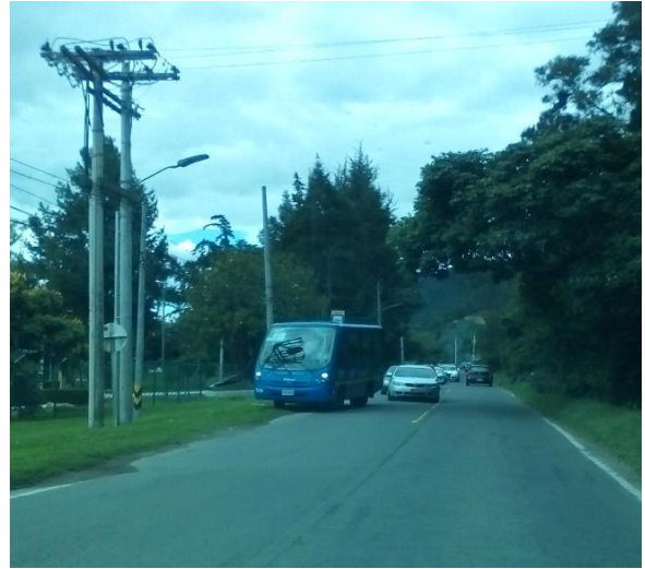
Foto No. 13: Paradero de bus SITP. Km 2+220.
