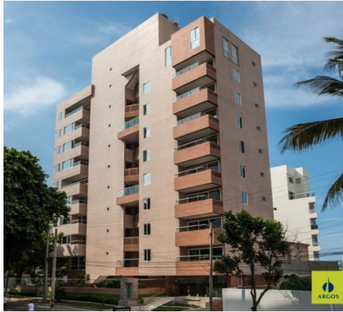
Edificio Viverdi 84 Barranquilla. Fuente: Argos
