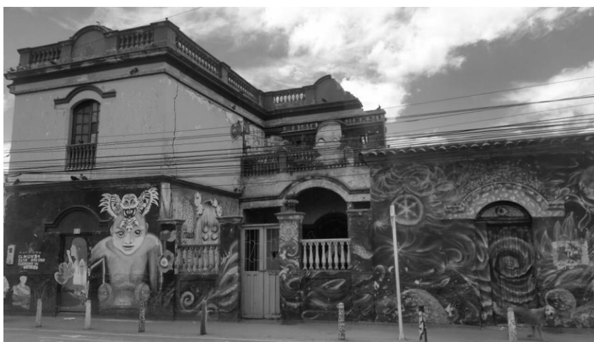
Foto 3. Fachada deteriorada por Carrera 9° del Antiguo Colegio Diosa Chía. Fuente: Propia.
