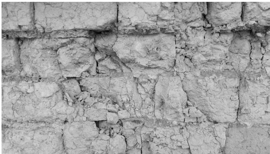
Foto 2. Muro a la Vista del BIC. Fuente: Propia, Tomada el 22 de abril de 2017.
