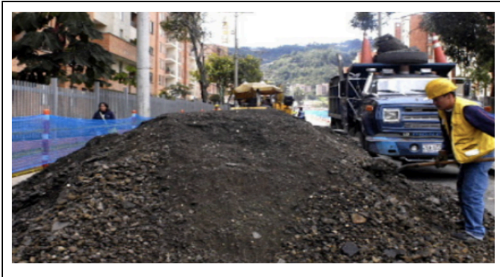
Fotografía 1. Obtención del RAP Fuente: Elaboración propia.
