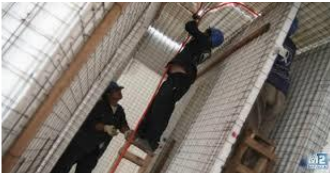
Imagen 14. Instalación de Durapanel para una vivienda. Fuente: Emmedue-M2, 2012
