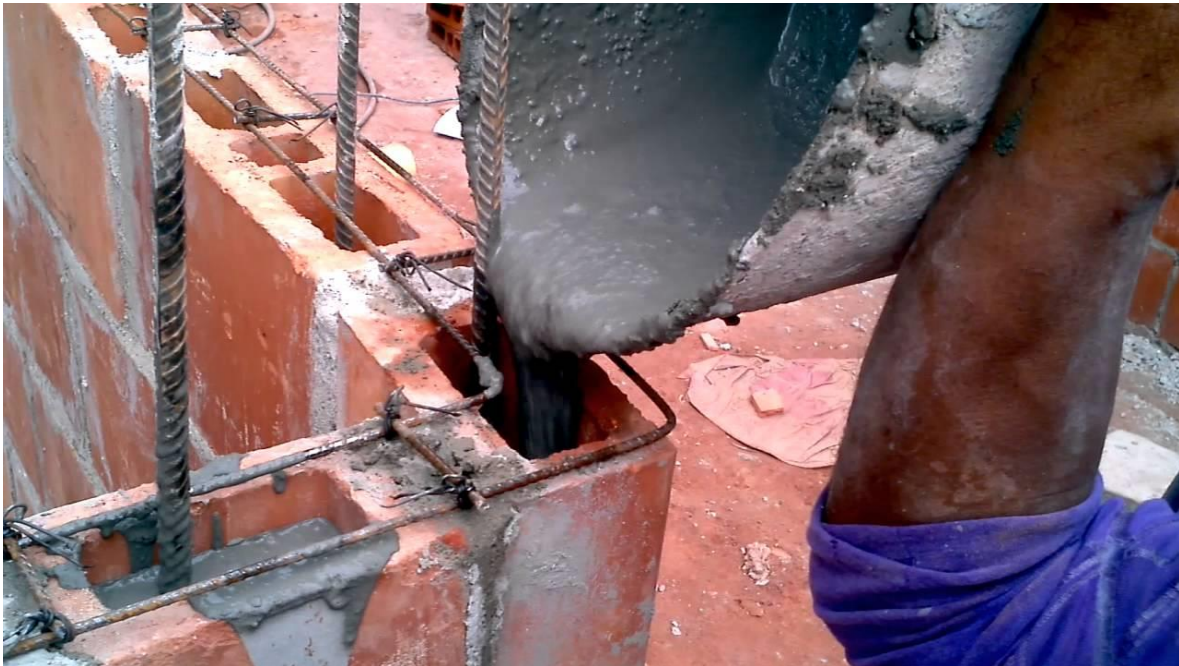
Imagen 13. Fotografía tomada en la fundida de las dovelas en obra mampostería estructural. Fuente: Propia.
