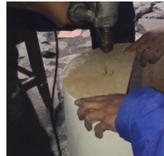
Figura 44 Perforación para manguera
