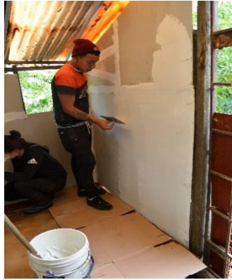
Figura 27 Estucar láminas de superboard
