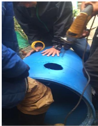
Figura 34 Perforar canecas industriales
