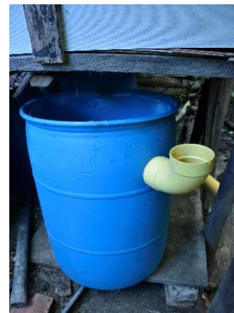
Figura 33 Ubicar tubo pvc en caneca industrial
