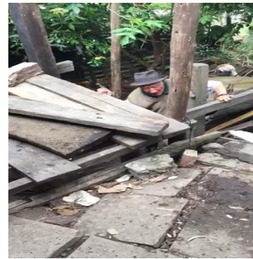
Figura 20 Ajustar y apuntillar planchones
