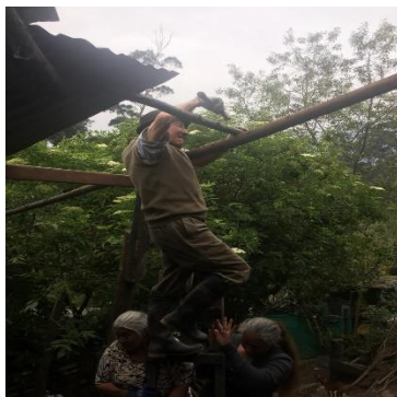
Figura 17 Ajustar y apuntillar madera rolliza
