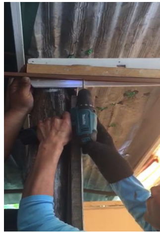
Figura 32 Atornillar riel de puerta corrediza
