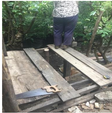
Figura 19 Ubicar planchones como entre piso
