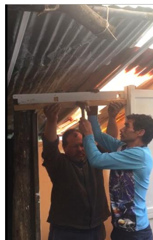
Figura 30 Ubicar y ajustar riel de la puerta
