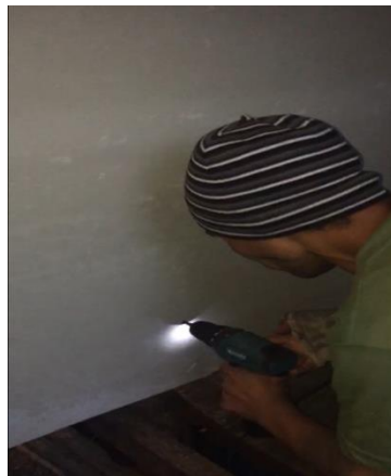
Figura 26 Atornillar láminas de superboard
