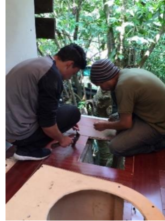
Figura 24 Apuntillar las láminas para ajustarlas y perforamos donde quedara el sanitario
