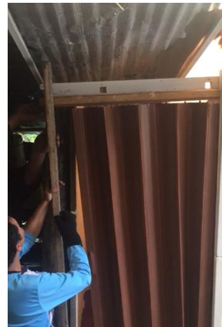
Figura 31 Instalar puerta corrediza
