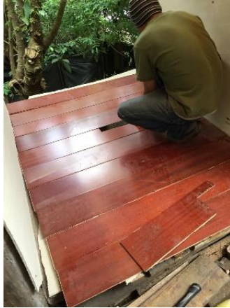
Figura 23 Ubicar las láminas del piso
