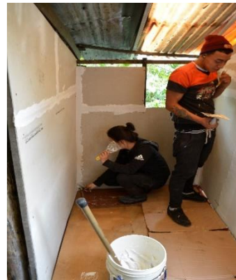
Figura 28 Estucar uniones de las laminas
