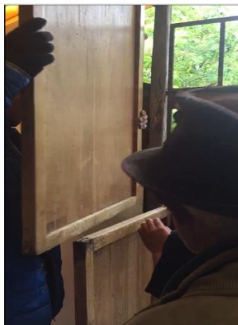
Figura 29 Ubicar y atornillar muro divisorio
