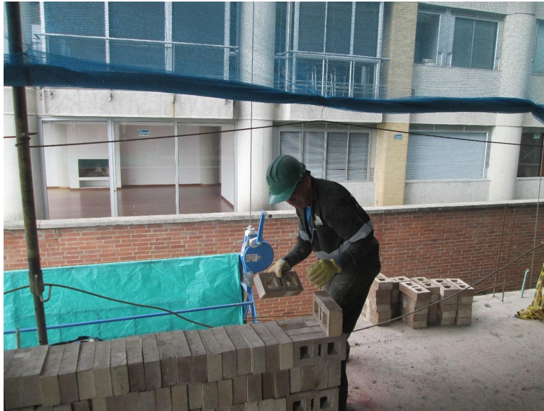
Sistema convencional de mampostería en arcilla reforzada.
