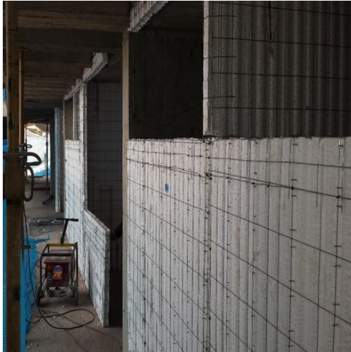
Sistema constructivo mampostería Emmedue M2
