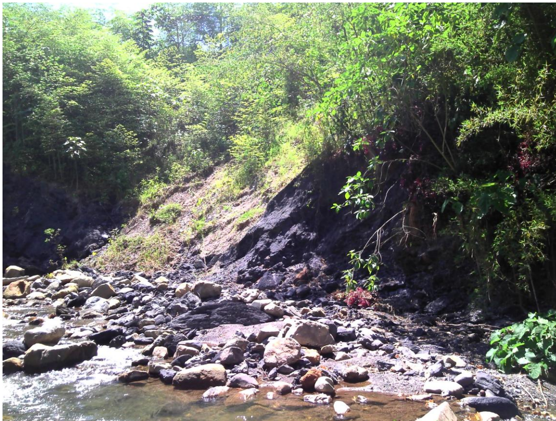
Fotografía 3. Deslizamientos sobre las laderas del cauce. Fuente propia
