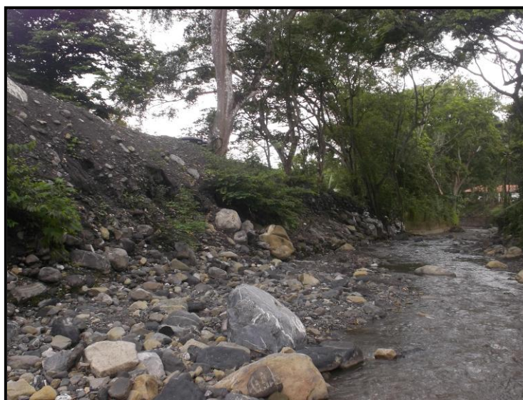
Jarillón a la altura del colegio Cune
