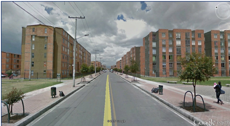
Figura 10. Construcción Vertical Barrio Tintala.
