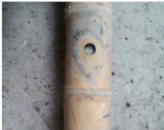
Figura 14. Retiro y limpieza del mortero 32 .
