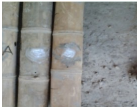
Figura 15. Aplicación de la masilla epóxica 33 .
