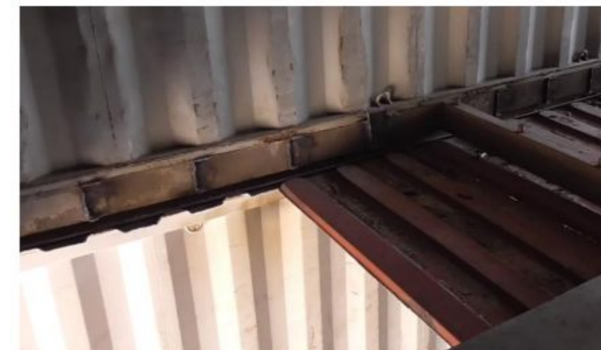
fig 23. Refuerzo escaleras - (Pacific Pines Ranch, 2018)
