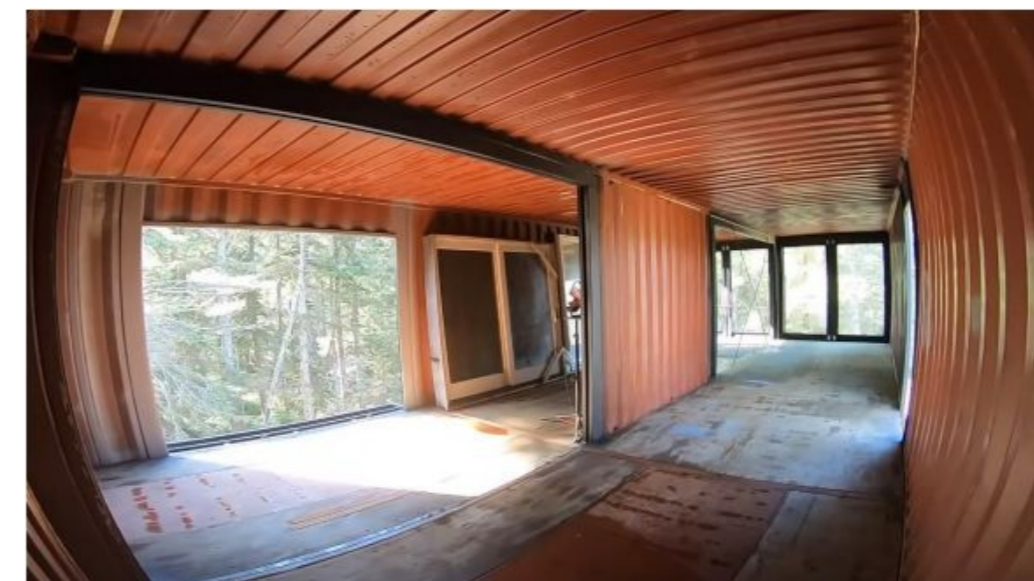
fig 21. Refuerzo con perfiles estructurales rectangulares (Pacific Pines Ranch, 2018)
