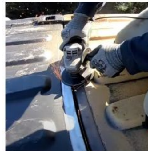
fig 17. Lijado de la superficie (Pacific Pines Ranch, 2018)
