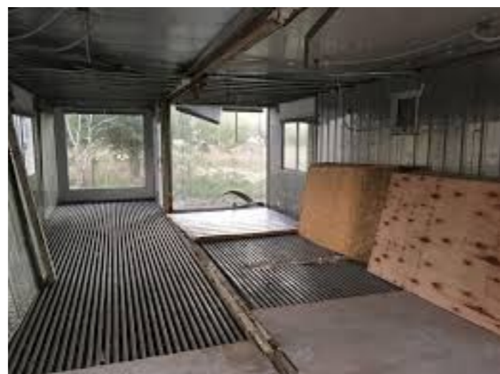
fig 36. Terminación y aislamiento pisos
