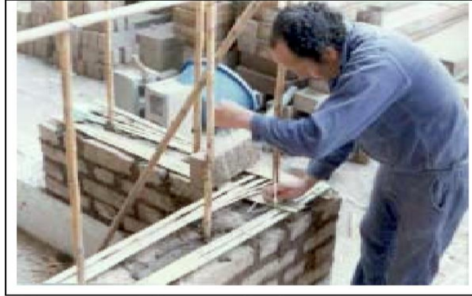
Ilustración 11. Reforzamiento con caña
