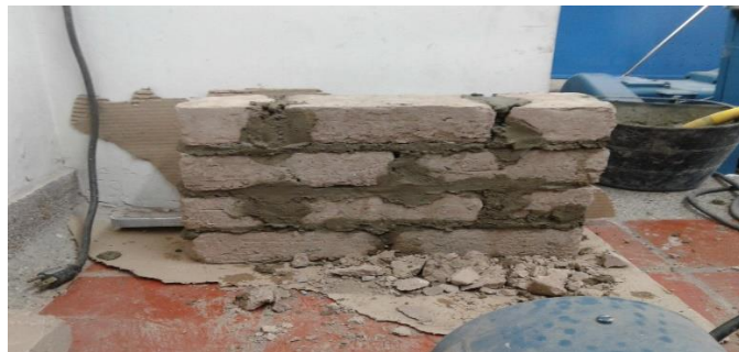
Ilustración 21 murete de adobe sin refuerzo. Fuente: Elaboración propia (2016)
