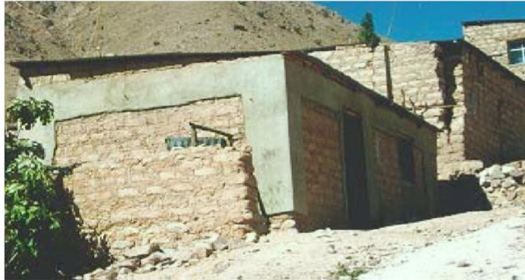
Ilustración 14. Casa de adobe reforzada con maya electro soldada
