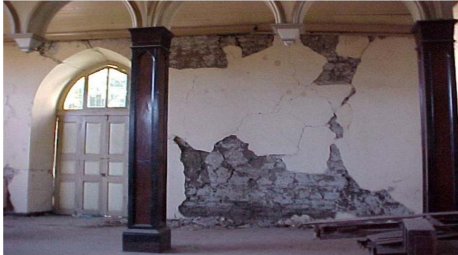
Ilustración 6 grietas diagonales
