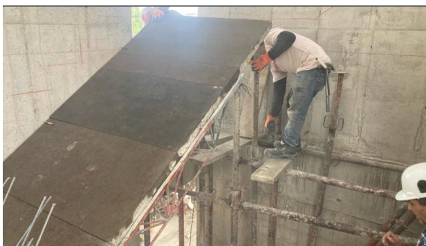
Figura 9 Encofrado de las escaleras pisos 6-7
