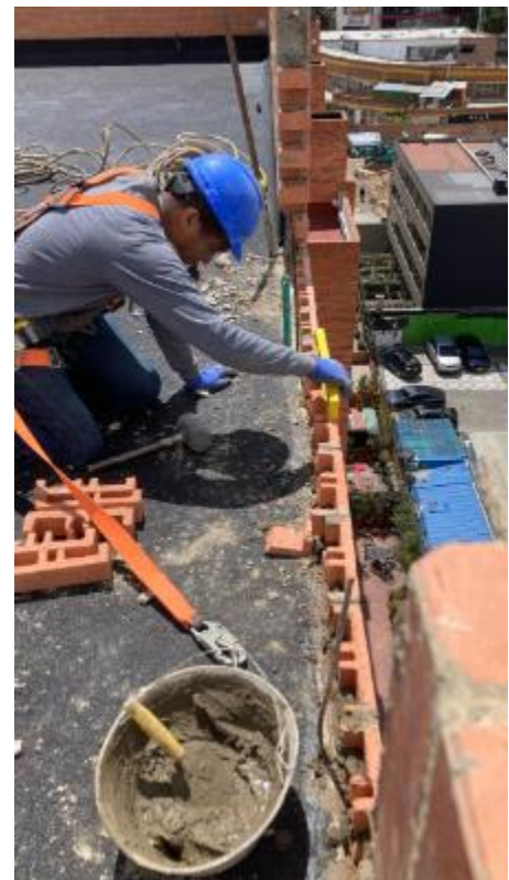
Figura 17 Culminación de Mampostería en cubierta
