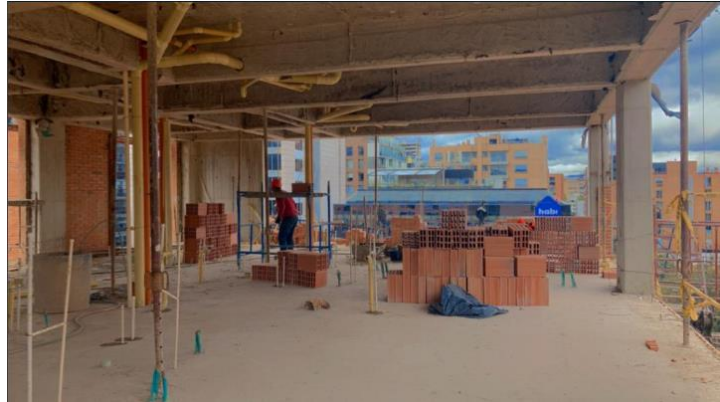
Figura 1 Acopio de mampostería piso 6
