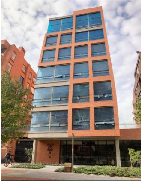
Figura 22 Fachada edificio Oruga 94
