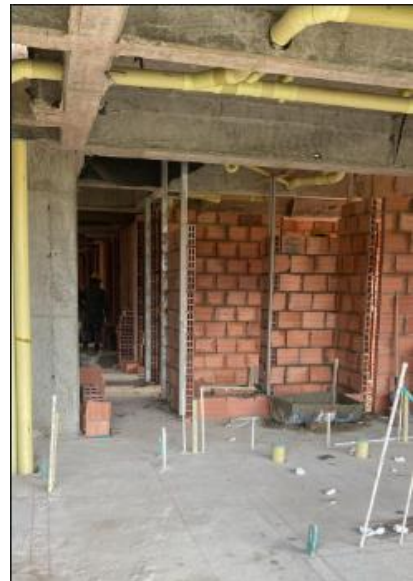
Figura 3 Replanteo de muros divisorios piso 5
