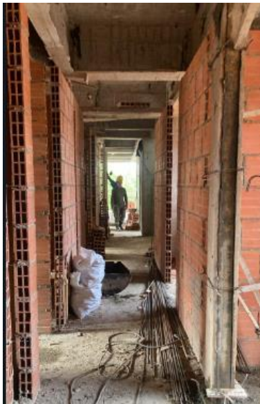
Figura 4 Mampostería y confinamiento con columnetas
