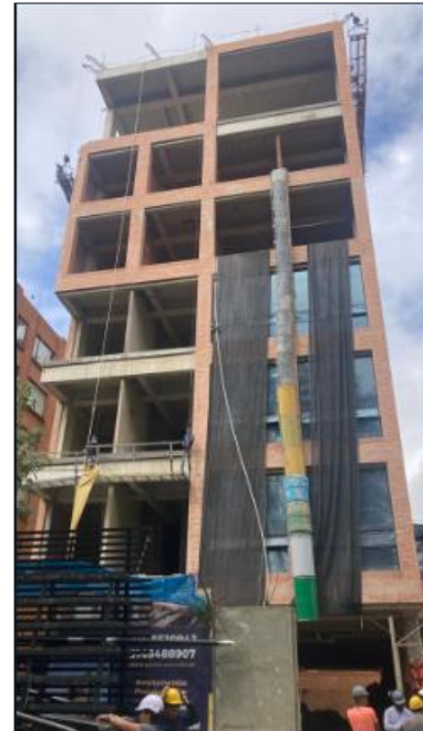
Figura 8 Fachada principal del edificio Oruga 94
