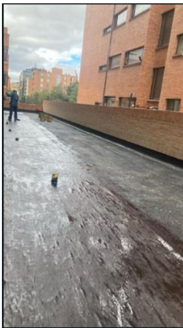
Figura 11 Impermeabilización terraza piso 2
