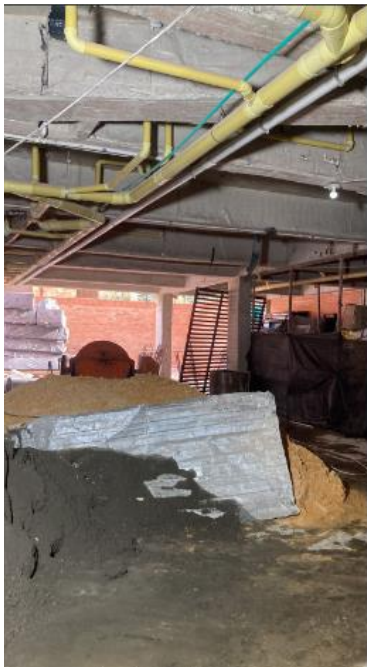
Figura 2 Acopio de arena piso 1
