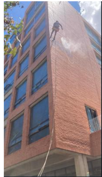
Figura 19 Impermeabilizado de la fachada occidental
