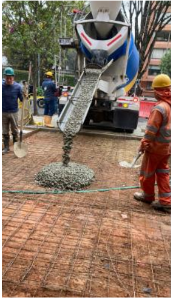
Figura 16 Vaciado del concreto en rampa de acceso vehicular
