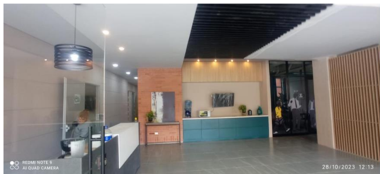
Figura 21 Avance de la adecuación del Lobby
