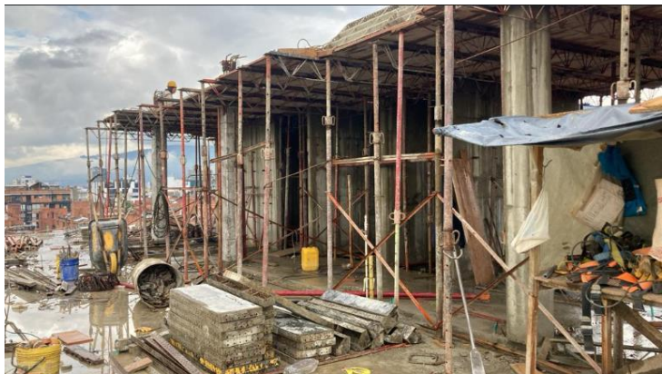
Figura 12 Formaleta de la placa de la sobrecubierta
