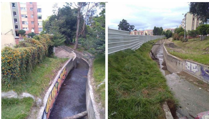
Figura 44 - Quebrada Serrezuela. Fotos de elaboración propia.
