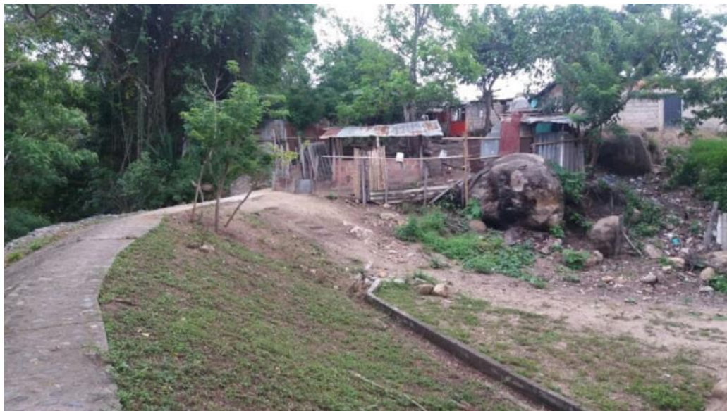
Figura 4 Problemáticas del parque longitudinal malecón (vivienda que interrumpe el paso del malecón)
