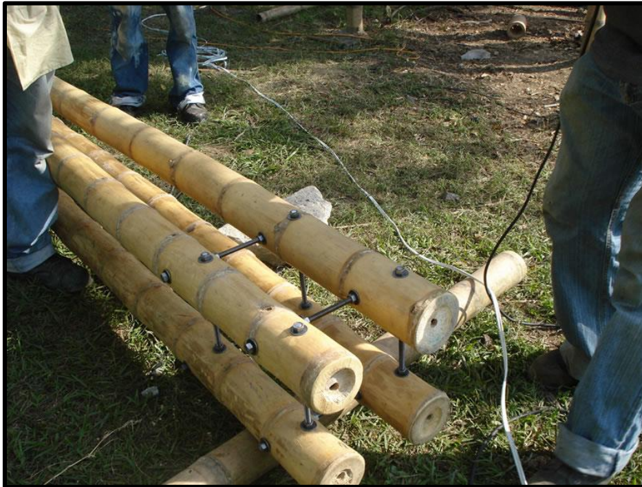
Figura 25. Guaduas tipo Castilla unidas para hacer una columna
