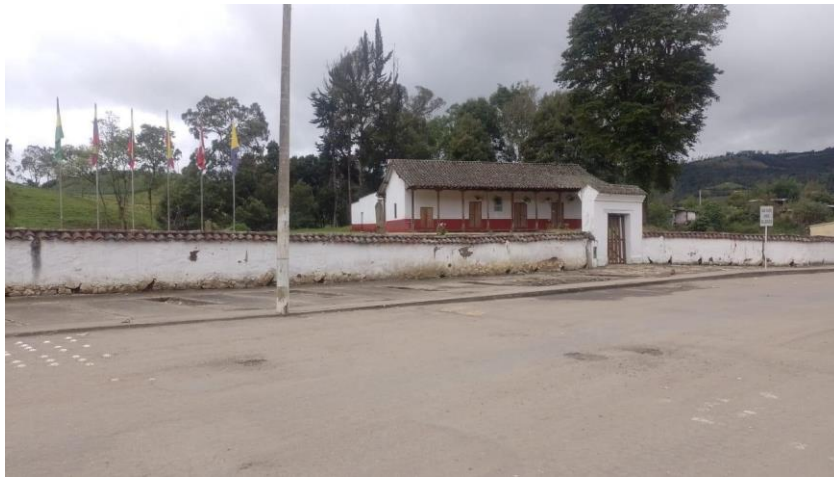
Figura 1 fachada casa cuartel general
