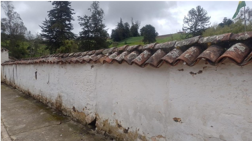
Figura 12 Foto muro externo
