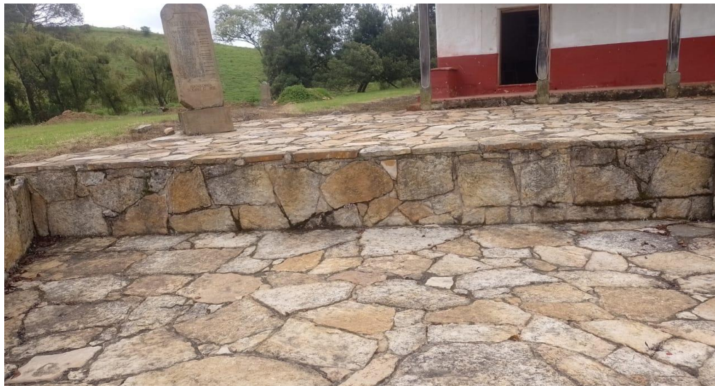
Figura 11 Foto ingreso edificación
