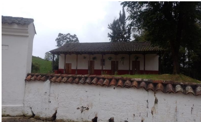
Figura 16 Muro externo fachada
