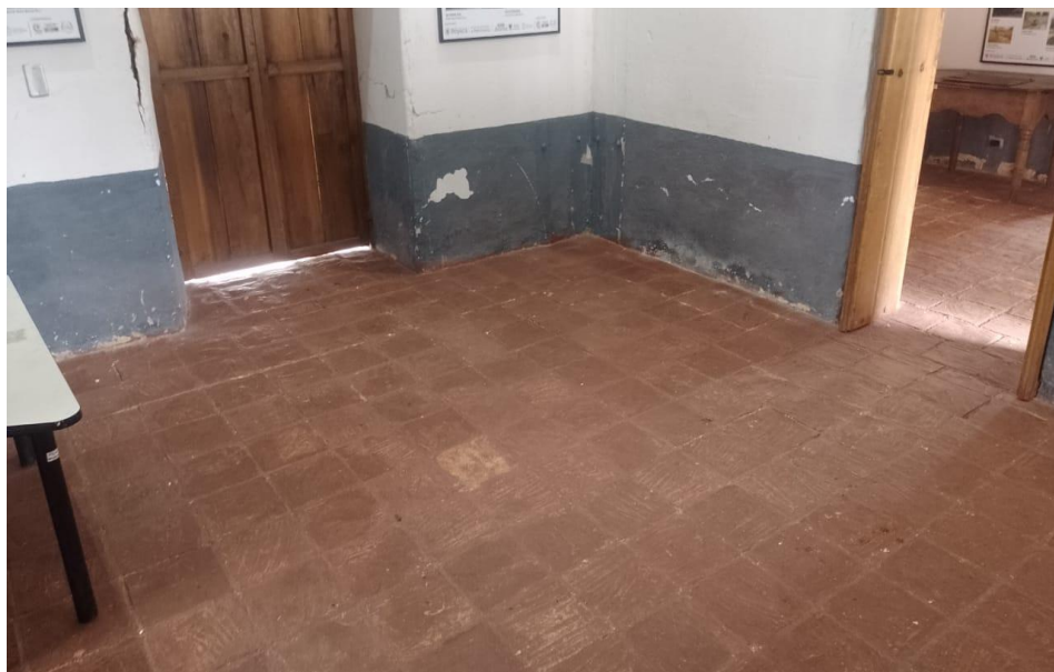
Figura 9 Piso existente casa cuartel
