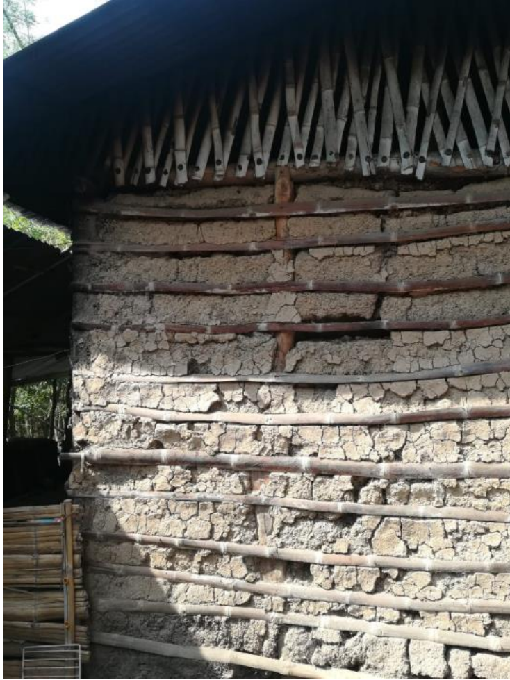
Figura 1 Pared de bahareque embutido. Elaboración propia.
