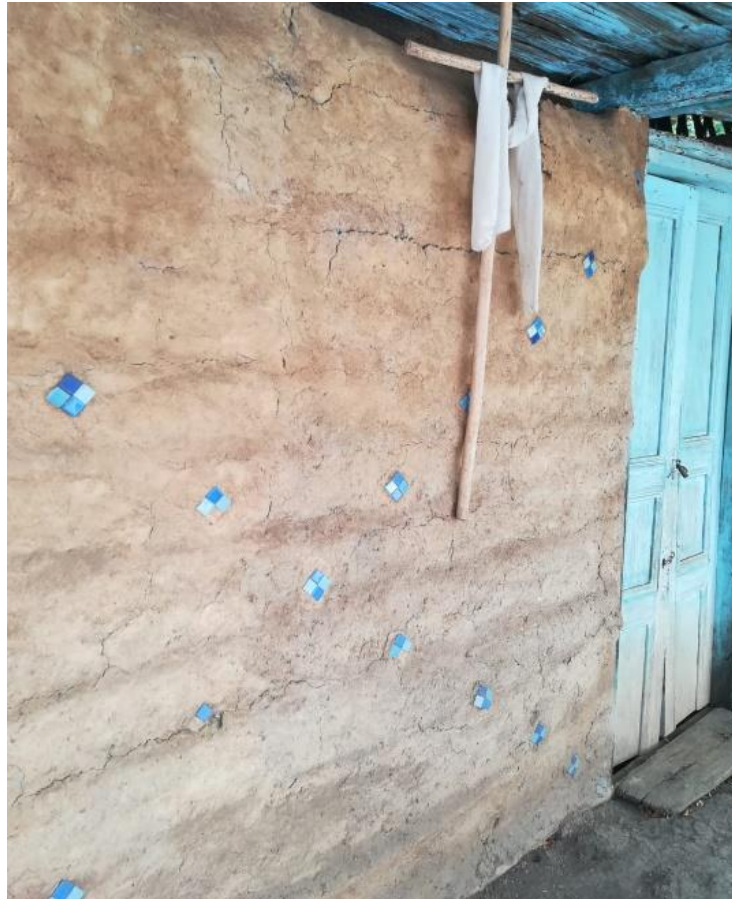
Figura 3 Pared de bahareque embutido pañetado con boñiga de caballo. Elaboración propia.
