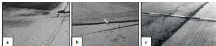
Desplazamiento de nivel de severidad bajo (a), medio (b) y alto (c).
