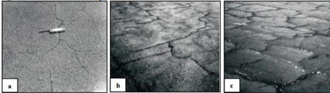
Fisuras en bloque de niveles de severidad bajo (a), medio (b) y alto (c).
