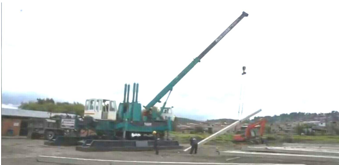
Figura 3 Izado de los pilotes
