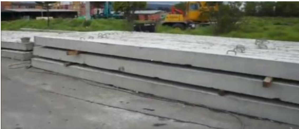
Figura 4 Almacenamiento de los pilotes.
