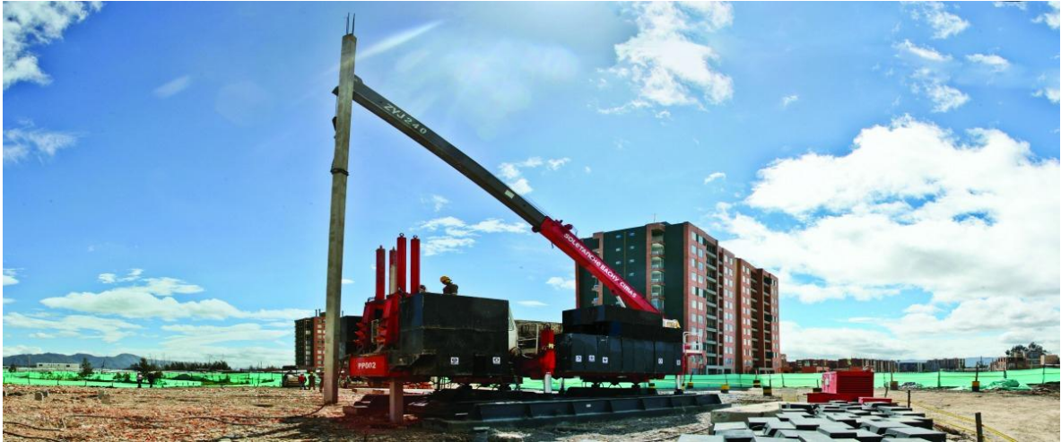
Figura 12 Pilotaje hincados a presión.
