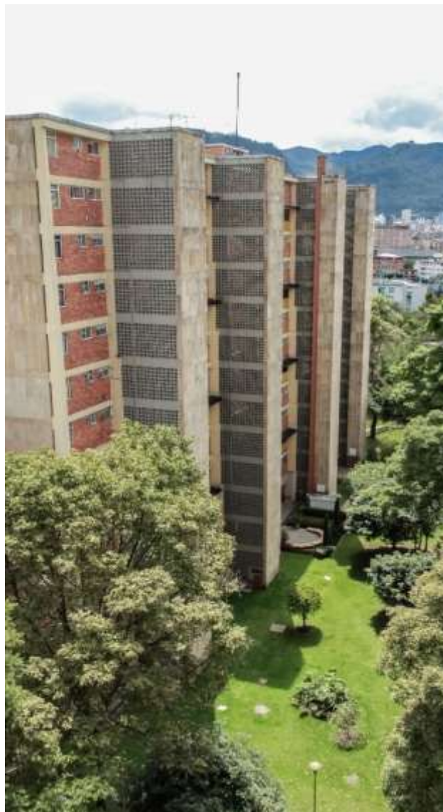
Figura 7: Bloques de vivienda Tipo B. Elaboración propia
