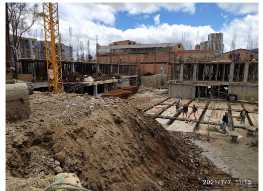
Ilustración 2: Construcción de estructura en etapas, tipo ajedrez .
