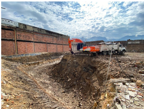
Ilustración 1: Excavación con talud y berma de acuerdo a recomendación del especialista
