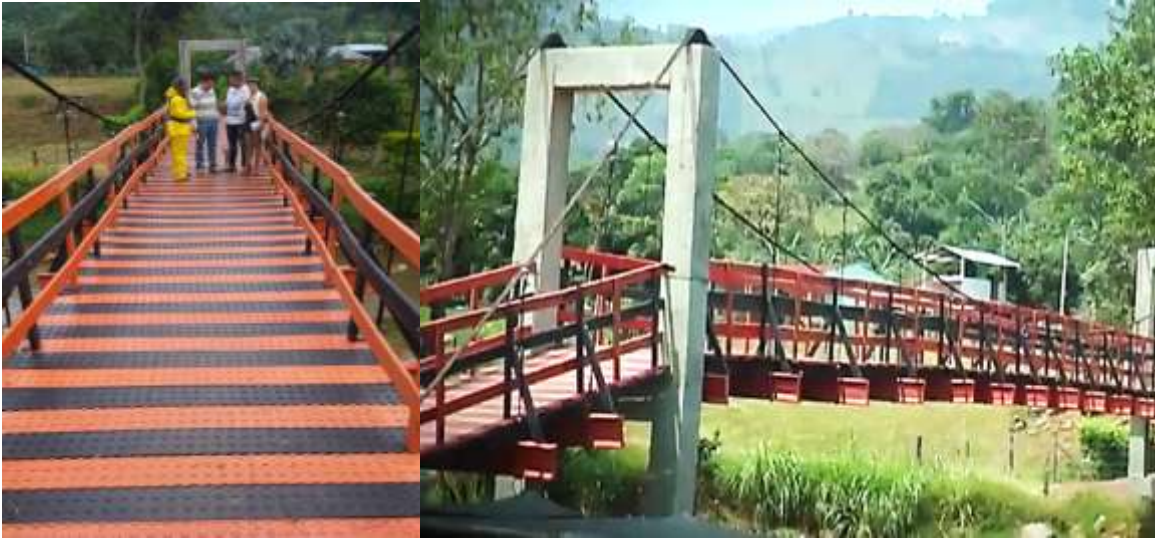
Ilustración 11: Puente colgante peatonal vereda el Tejar, municipio de Timaná.
