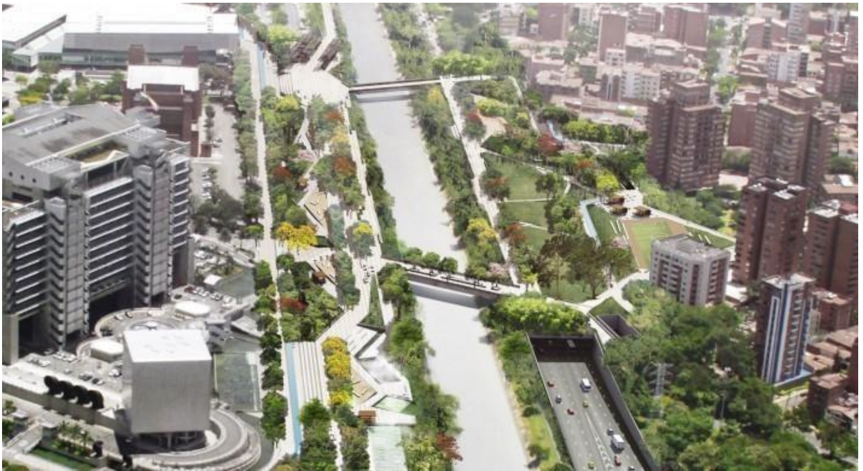
Figura 24. Parques del Río. M. Bonilla, 2015, Tomado de ¿Deben o no continuar las obras de Parques del Río? Opinan los candidatos a la Alcaldía de Medellín. Recuperado de https://www.archdaily.co/co/775688/deben-o-no-continuar-las-obras-de-parques-del-rio-opinan-los-candida
