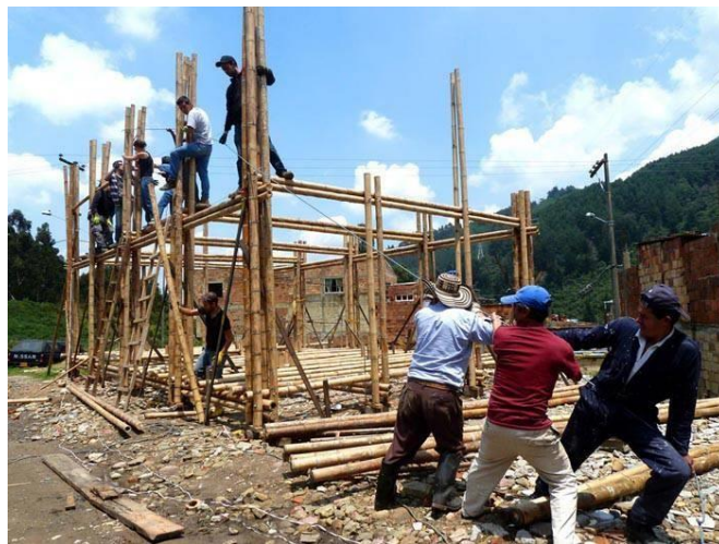
Figura 31. La Casa de la Lluvia [de ideas] Construcción. Arquitectura Expandida, 2015, Tomado de LA CASA DE LA LLUVIA [DE IDEAS] (SAN CRISTÓBAL, BOGOTÁ). Recuperado de http://arquitecturaexpandida.org/la-casa-de-la-lluvia-de-ideas-en-proceso/
