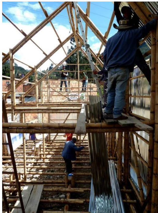
Figura 32. La Casa de la Lluvia [de ideas] Construcción 2. Arquitectura Expandida, 2015, Tomado de LA CASA DE LA LLUVIA [DE IDEAS] (SAN CRISTÓBAL, BOGOTÁ). Recuperado de http://arquitecturaexpandida.org/la-casa-de-la-lluvia-de-ideas-en-proceso/
