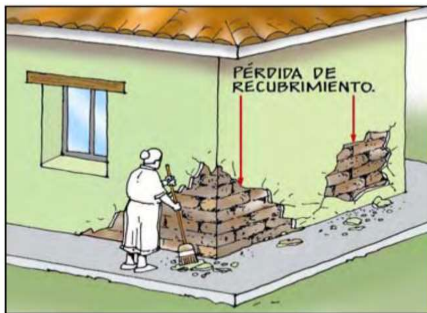
Figura 18. Recubrimiento realizados con cemento y material que no se compacta con la tierra; tomado de Asociación Colombiana de Ingeniería Sísmica – AIS (s.f )
