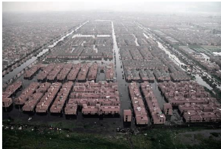
Figura 11. Inundación Patio Bonito.
