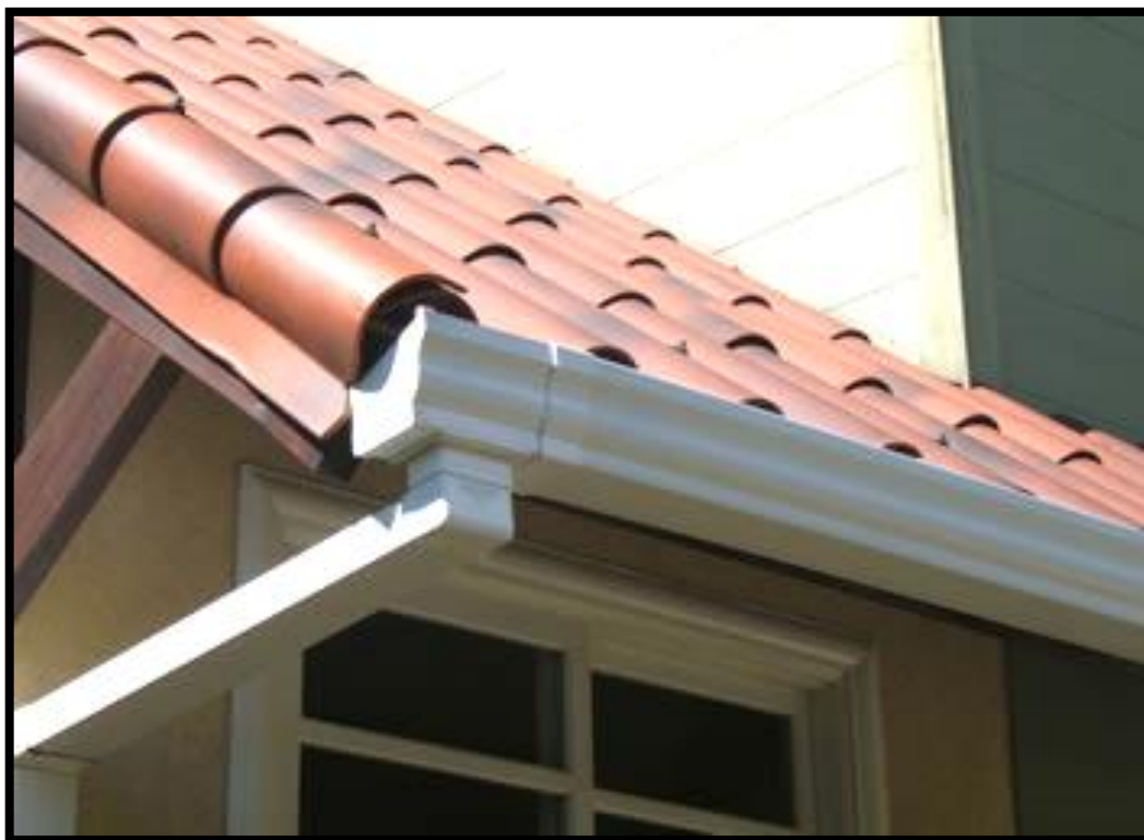
Ilustración 3 Sistema de conducción
