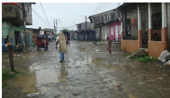
Figura 12. Estado de las calles aledañas a la zona de intervención. Fuente: Propia, 2016.
