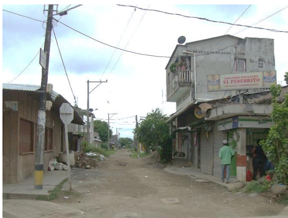
Figura 6. Estado de vías en zonas de borde urbano.
