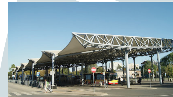
Dworzec Wschodni (Lubelska)
