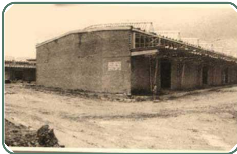
Figura 11 Inicio de la construcción de las bodegas de Corabastos
