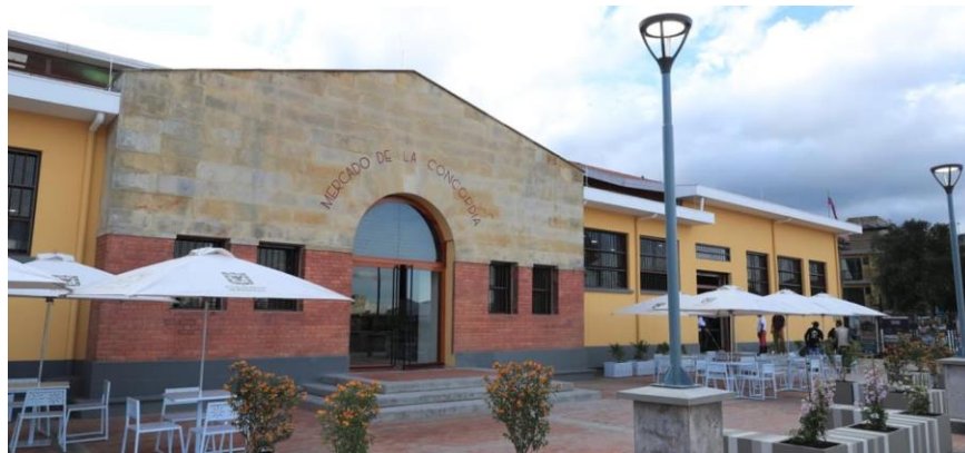
Figura 9 Fachada exterior Plaza de La Concordia
