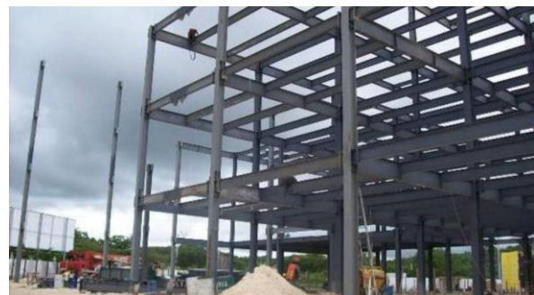
Figura 5 Armazón en estructura metálica
