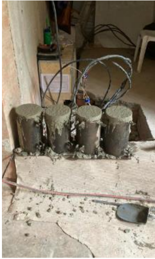
Figura 2 Toma de testigos de concreto
