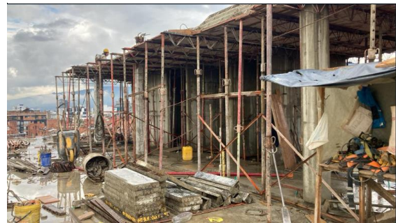
Figura 4 Fundición monolítica de sobrecubierta
