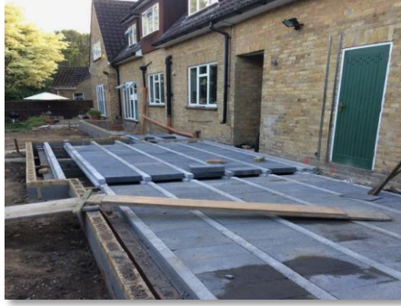
IMAGEN 8 Paneles de concreto prefabricado para refuerzo de estructuras
