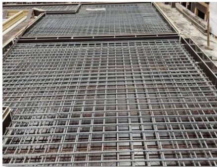
IMAGEN 4 Placas de acero para refuerzo de estructuras
