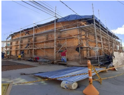
IMAGEN 2 Mallas electrosoldadas para refuerzo de mampostería
