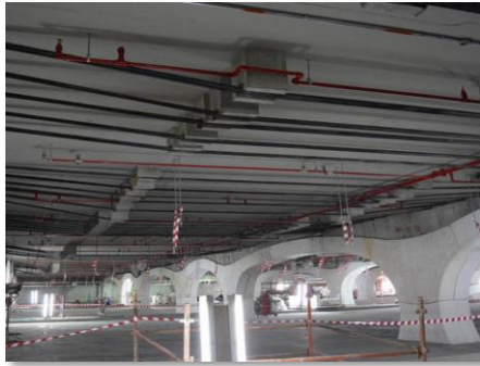
IMAGEN 9 Sistemas de postensado para refuerzo de estructuras
