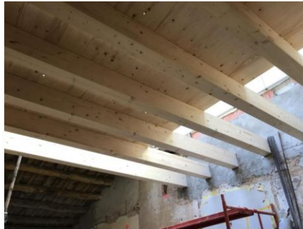
IMAGEN 7 Piezas de madera laminada para refuerzo de estructuras
