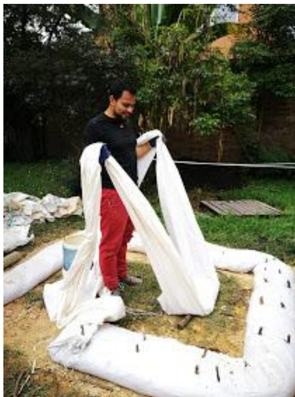
Ilustración 11 colocación de estacas de madera sobre las lona
