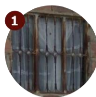
Oxidación por exposición
