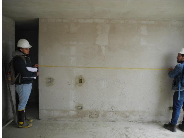
Ilustración 8: Metreado muros en concreto.
