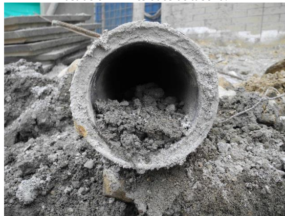
Ilustración 12 Residuos de tubería.
