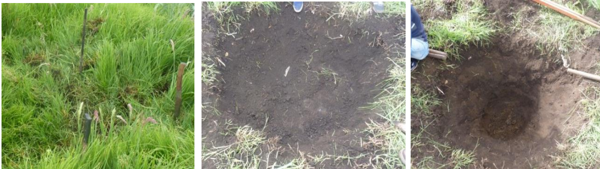
Imagen 22. Proceso de excavación de hoyo.
