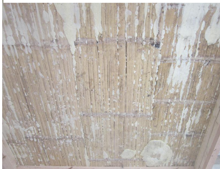
Imagen 6. Guadua laminada con exceso de pegante
