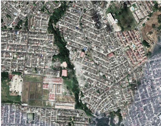
Figura 11 . Delimitación del área de intervención. Elaboración propia, Tomado de Alcaldía de Villavicencio delimitación del área de intervención
