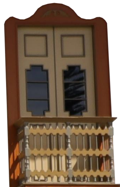
Imagen 6 Balcón, Calle 7 #5-36, Aguadas, Caldas. Fuente: Propia.
