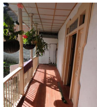
Imagen 2 Carrera 4 #2-65, Aguadas, Caldas. Fuente: Propia.
