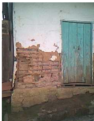
Imagen 3 Detalle constructivos. Fuente: Archivo fotográfico del plan especial de protección de Aguadas, Caldas.
