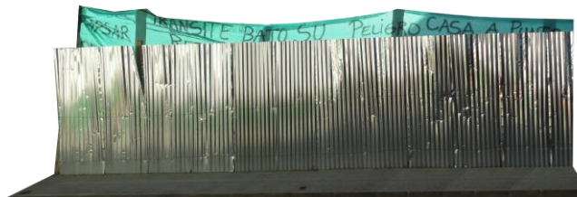
Imagen 19 Estado actual Carrera 5 #5-19, Aguadas, Caldas. Fuente: Propia.
