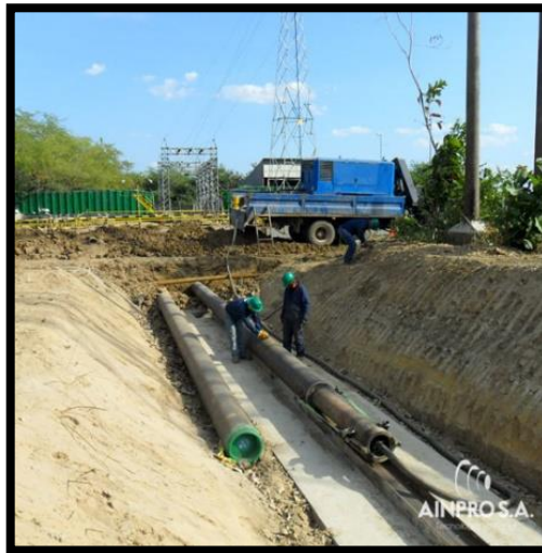
Ilustración 13 Ejecución proceso perforación horizontal por ramming
