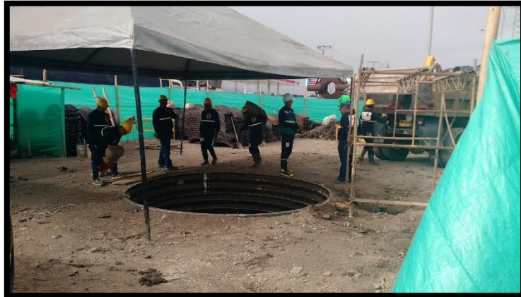
Ilustración 14 Construcción de pozos de inspección
