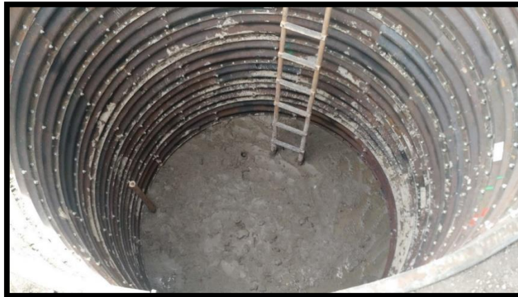
Ilustración 15 Encamisado para construcción de pozo y cámara de lanzamiento de ramming
