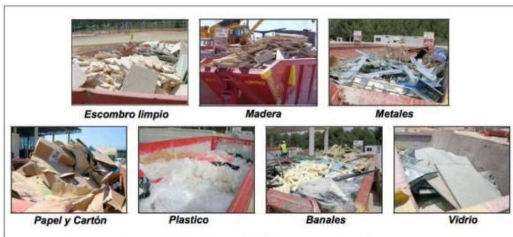
Figura 5. Tipos de escombros generados en obra. http://www.colmayor.edu.co/archivos/31_alma_cadavidevaluacin_manej_dbzxr.pdf
