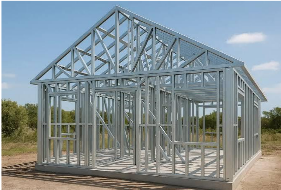
Ilustración 2 Esquema de estructural con Steel Framing
