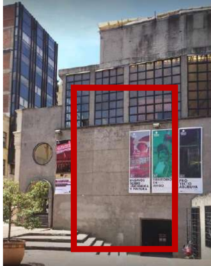
Equation 8. Espacio Odeón. Adaptado de "Espacio Odeón: un caso de recuperación del patrimonio arquitectónico en Bogotá" por Espacio Odeon, 2015. Recuperado de https://n9.cl/amdi
