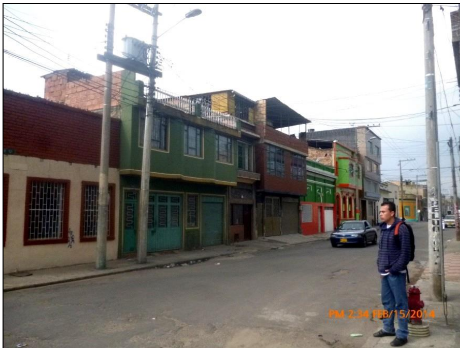
Figura 7. Cuenta con el 50% de la estructura vial en deterioro.
