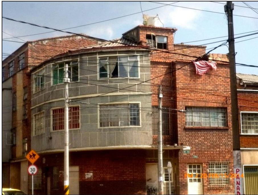
Figura 6. La altura predominante de las edificaciones es de tres (3) pisos.
