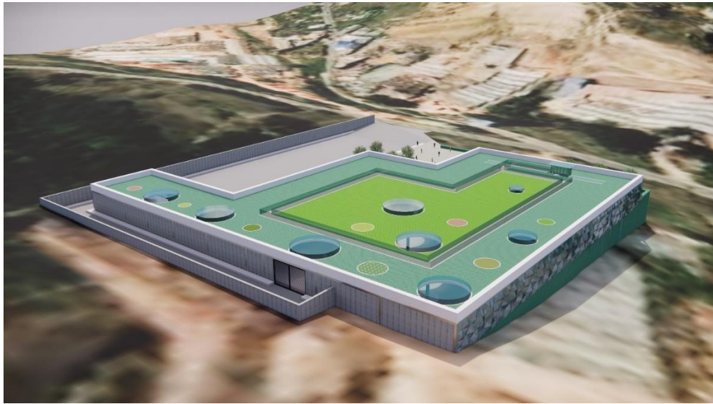
Figura 12 Planta de Clasificación y Procesamiento de Residuos Sólidos
