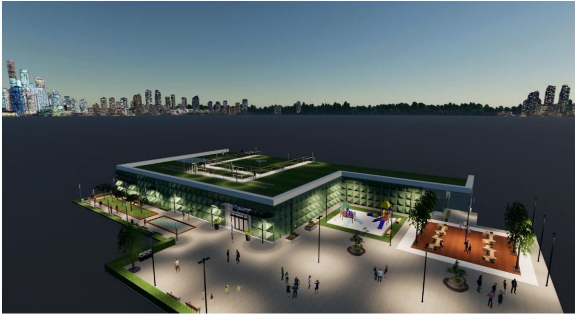
Figura 71 Exterior de la planta
