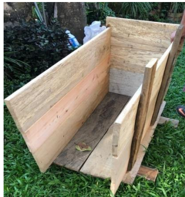
Figura 74. Encofrado
