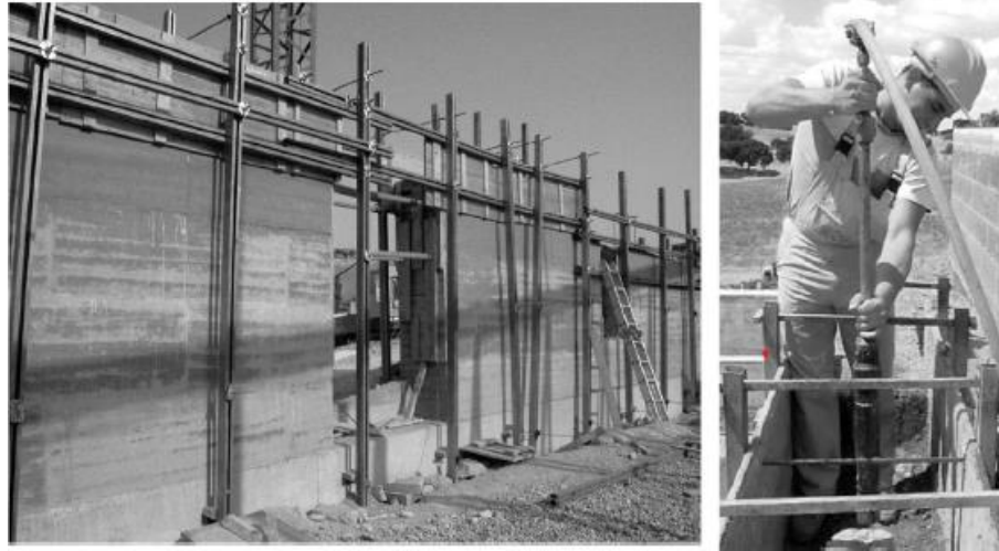
Figura 16. Construcción muro de tapia.
