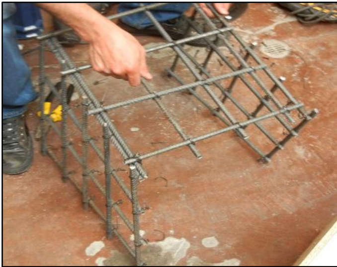
Fotografía 29. Parrilla en varilla de 3/8
