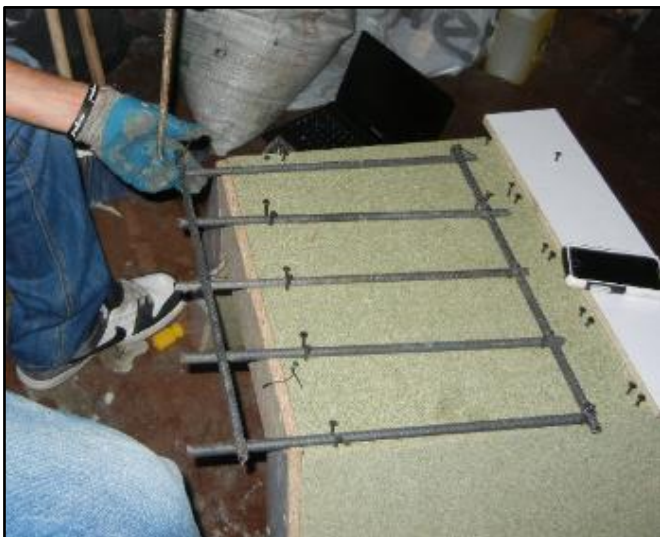
Fotografía 28. Amarrado de parrilla en varilla corrugada de 3/8".
