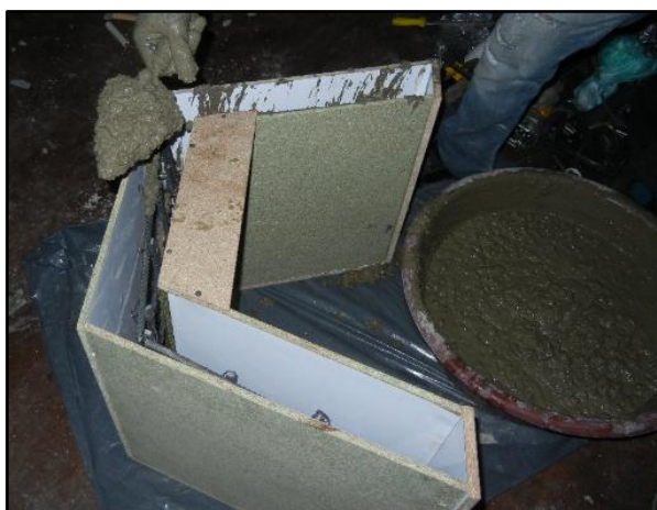
Fotografía 32. Vaciado de la silla para mobiliario urbano.
