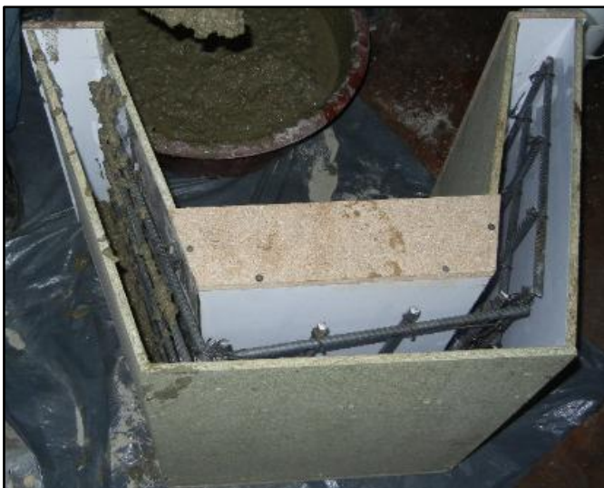
Fotografía 30. Estructura de la silla montada en la formaleta
