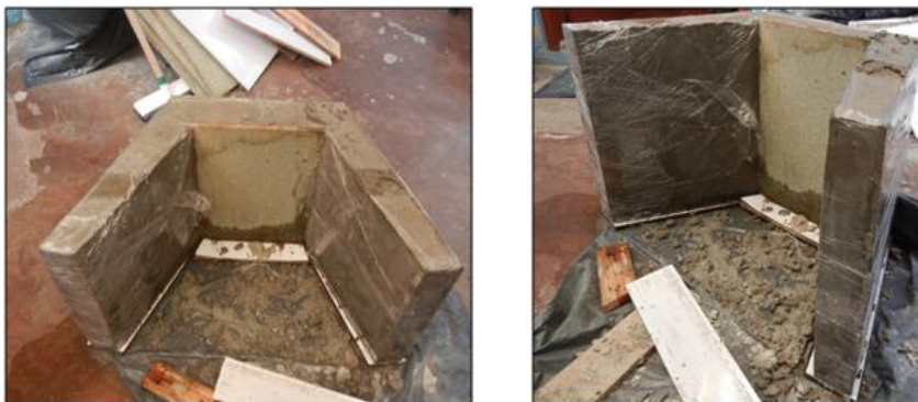
Fotografía 35. Desencofre y curado de la silla
