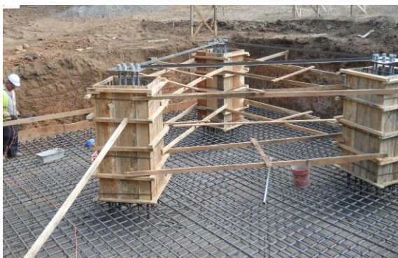
Figura 9. Pre-armado de cimentación de la torre.
