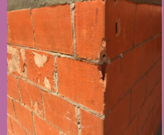
DEGRADACIÓN DEL LADRILLO EXPUESTO INTERNAMENTE POR EL MORTERO
