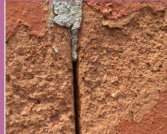
DEGRADACIÓN DEL LADRILLO EXPUESTO INTERNAMENTE POR EL MORTERO
