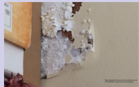
revoque de material con impurezas, docificaciones alteradas
