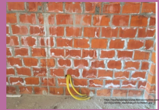
EJECUCIÓN DE OBRA
