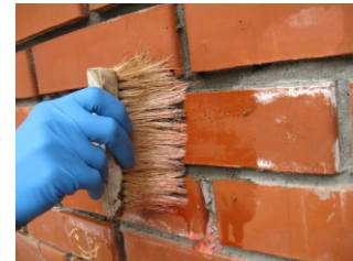
Tratamiento de la eflorescencia de acuerdo al compuesto químico que la compone
